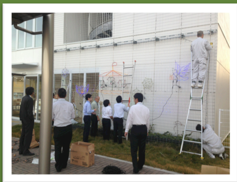
レストラン棟壁面イルミネーション設置風景
